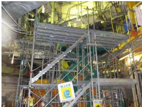
X100Bペネ下 (作業架台：高さ約4m)
