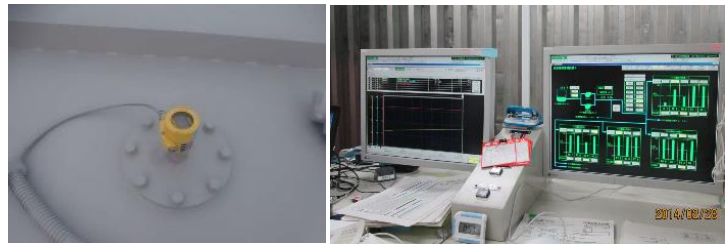
貯留タンク水位計 水位監視画面 貯留タンクの水位監視
