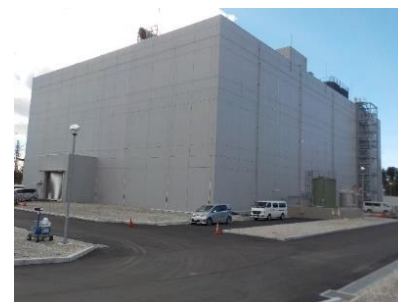
④-1 雑固体廃棄物焼却設備の外観 (2016年3月より運用開始)
