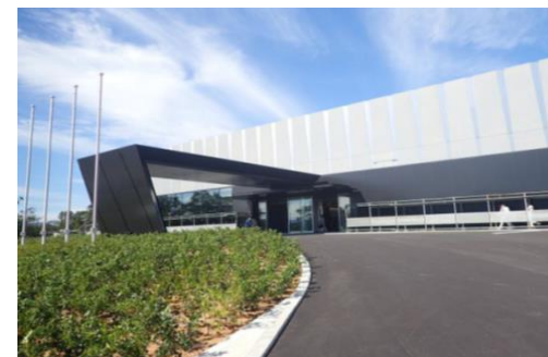
新事務本館 外観
