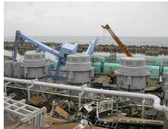
5号機海水ポンプ及び護岸（震災後）
