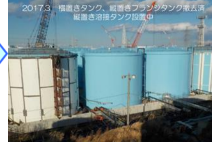
横置き・フランジタンクリプレース状況 (H2タンクエリアの例)
