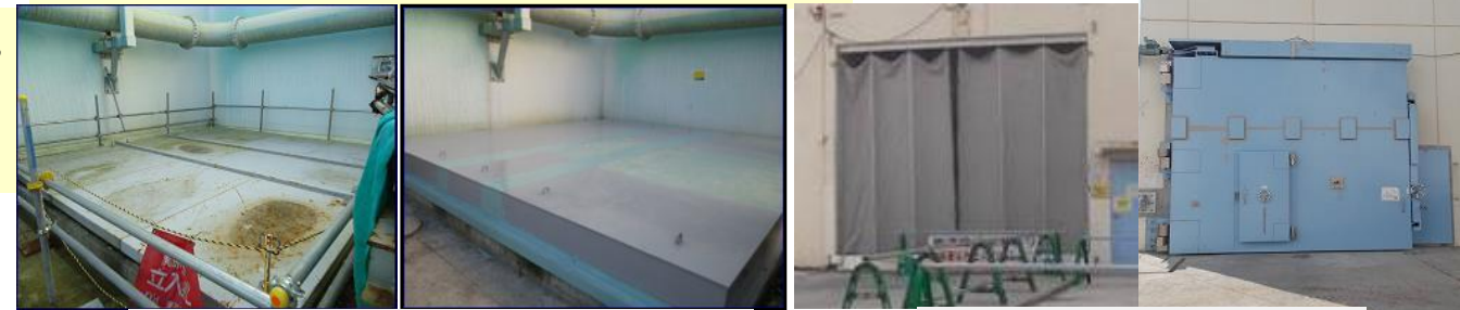
屋外の機器搬入開口の蓋を耐津波仕様に変更して防水処理を実施(1号タービン建屋)
