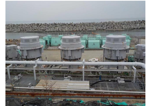
5号機海水ポンプ及び護岸（復旧後）
