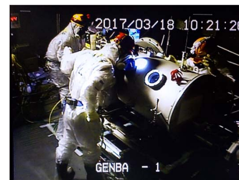
PCV外部での作業の様子
