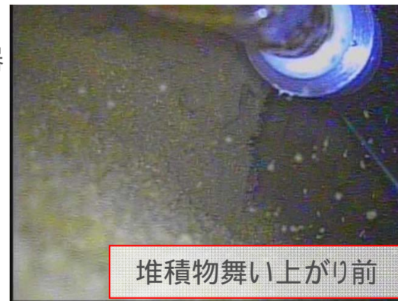
常設監視計器再設置時の堆積物の状況
