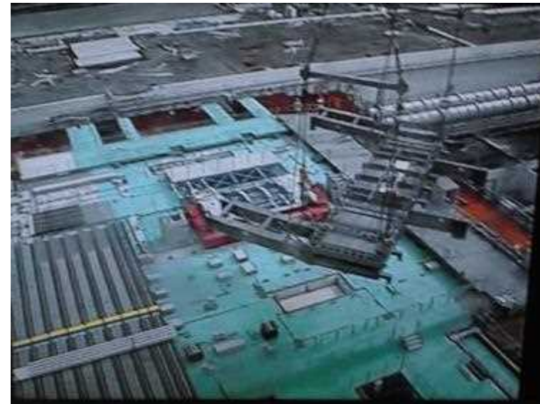
西側ストッパ設置状況（撮影日2017年2月7日）
