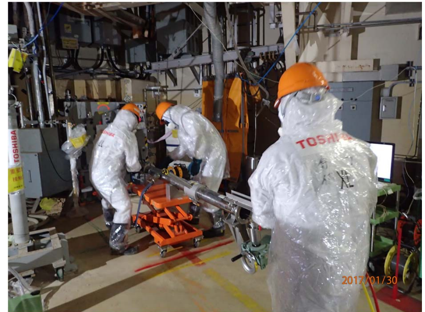
【2号機原子炉建屋内】
