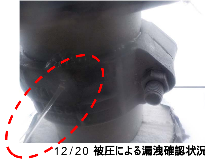
12/19 ブライン漏洩状況 (漏洩元付近被覆材継目)
