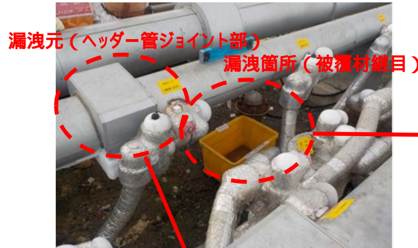
12/19 漏洩箇所 (凍結管670-1T付近)
