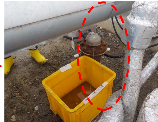
12/19 ブライン漏洩状況 (漏洩元付近被覆材継目)
