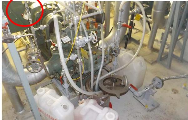
軸受冷却水配管ベント状況
