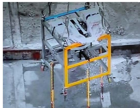
クレーンによる遠隔操作状況
