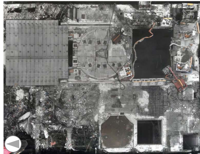
除染・遮へい体設置・プール内大型ガレキ撤去 並行実施 （撮影日2015年11月3日）
