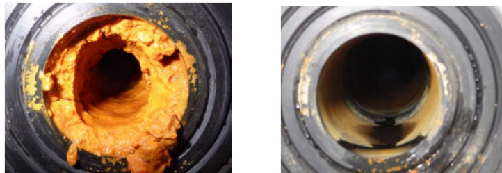
配管清掃状況
