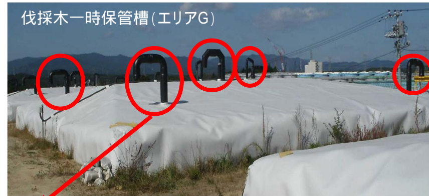
ガス抜き管(中央部, 四隅)
