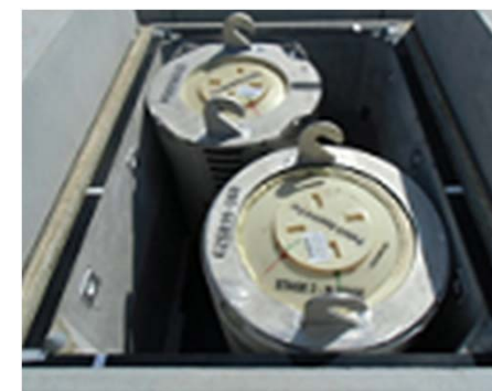
(コンクリート蓋設置前)
