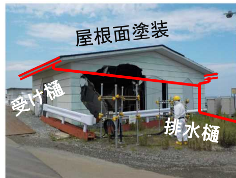
屋根塗装＋雨樋設置
