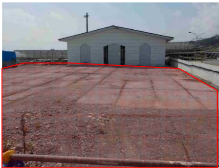
砂利部のアスファルト舗装
