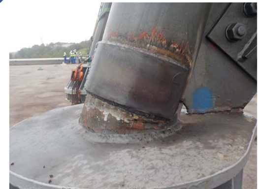
溶接による補修
