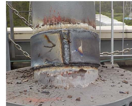
溶接による補修
