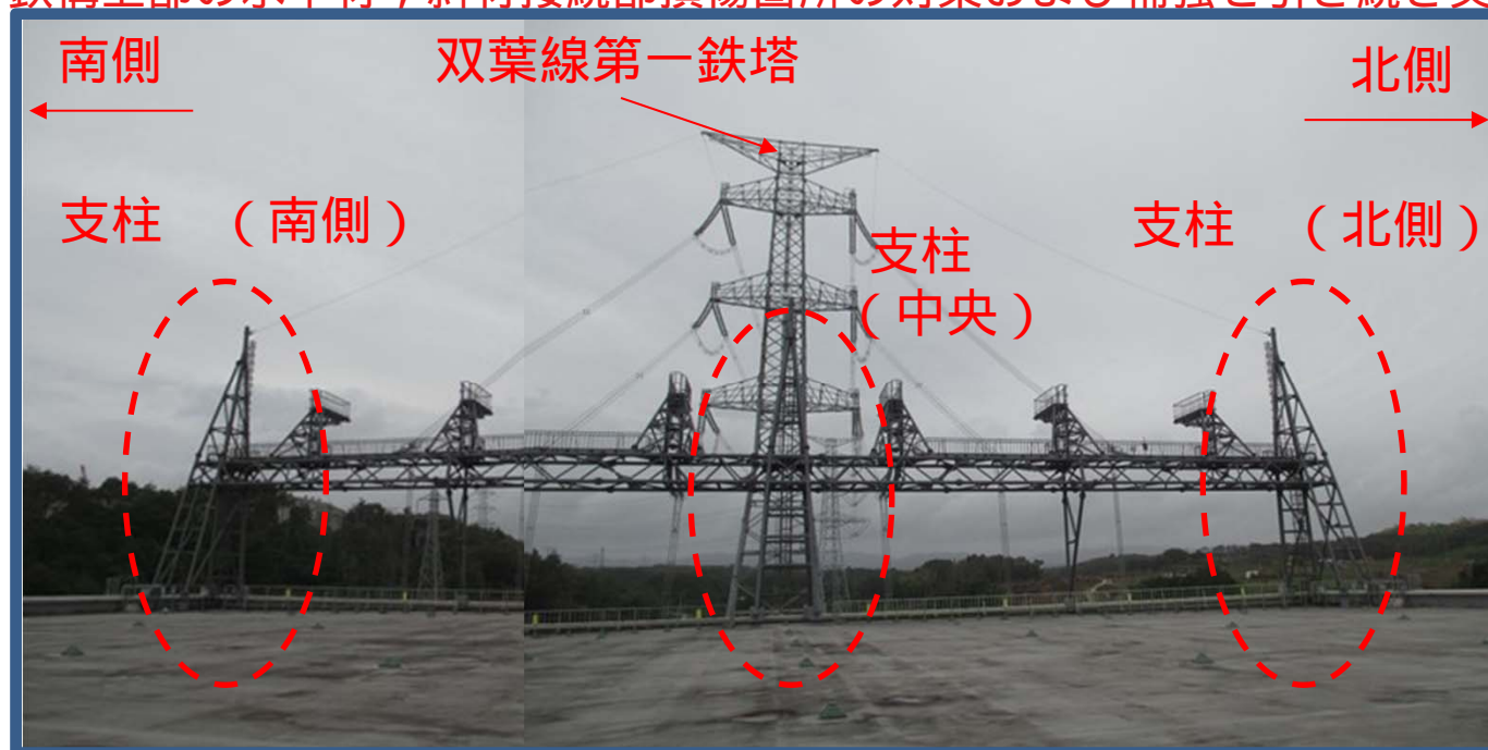
5,6号開閉所屋上から見た引留鉄構の外観
