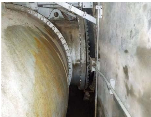
【1号機の現況5/18】 ※写真は左右反転
