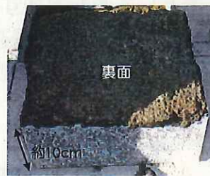
切り出したアスファルト
