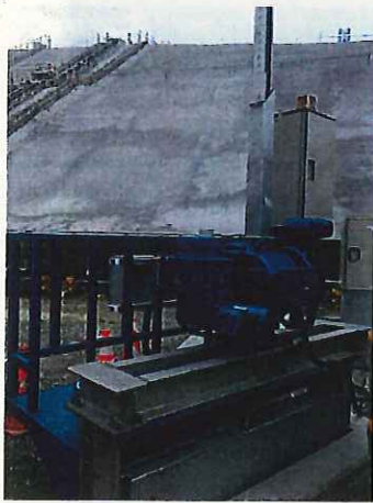
付替排水路ゲート設置状況
