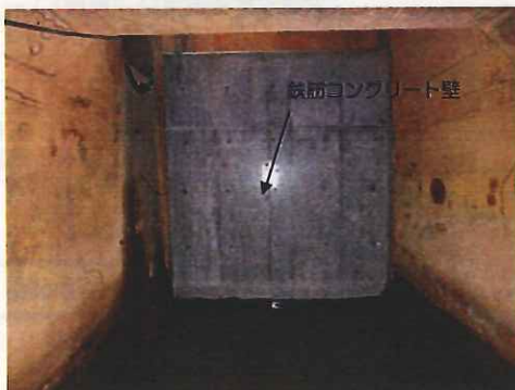
既設ルートの閉止状況
