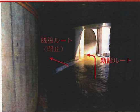
K排水路付替部
