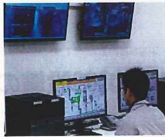
制御室 試験作業状況
