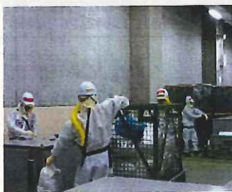
廃棄物充填エリア 廃棄物充填作業状況
