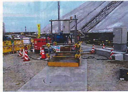
K排水路付替部 (埋戻し済み)
