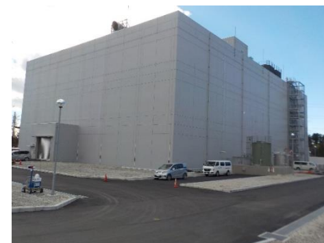
雑固体廃棄物焼却設備 建屋全景
