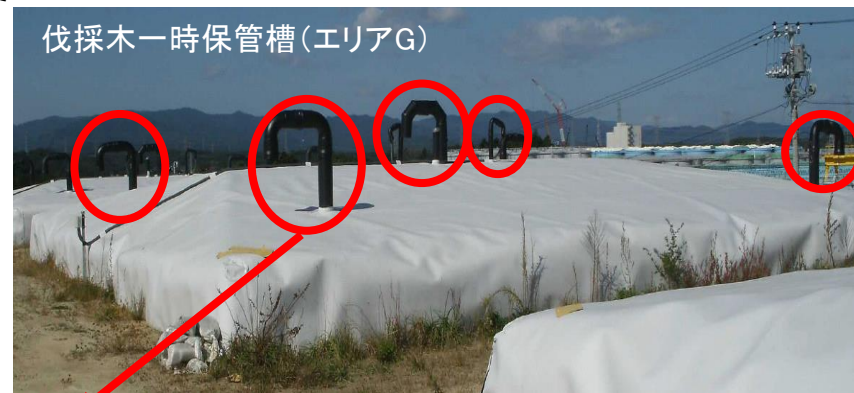
ガス抜き管(中央部, 四隅)
