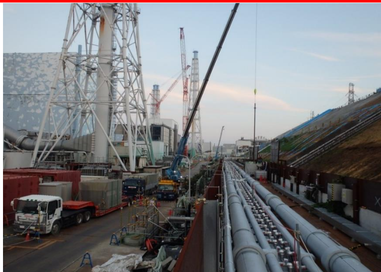
山側 (2~4号建屋西側) 施工完了状況
