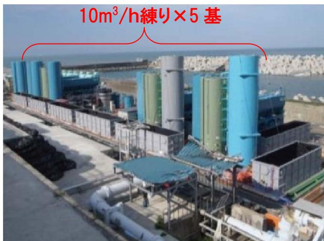
専用の製造プラント(福島第一原子力発電所構内、製造能力 50m<sup>3</sup>/h)
