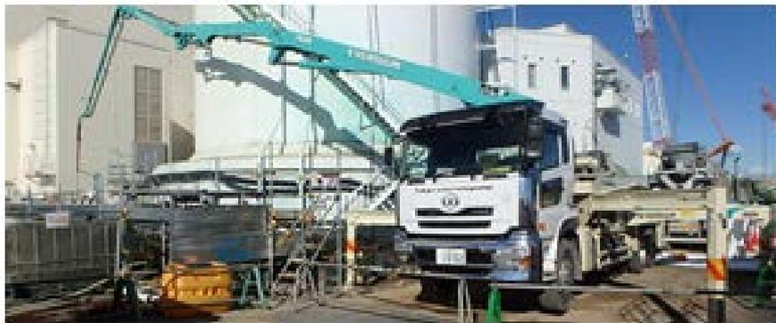
施工状況(「Hilo」の品質管理、運搬、打込み)
