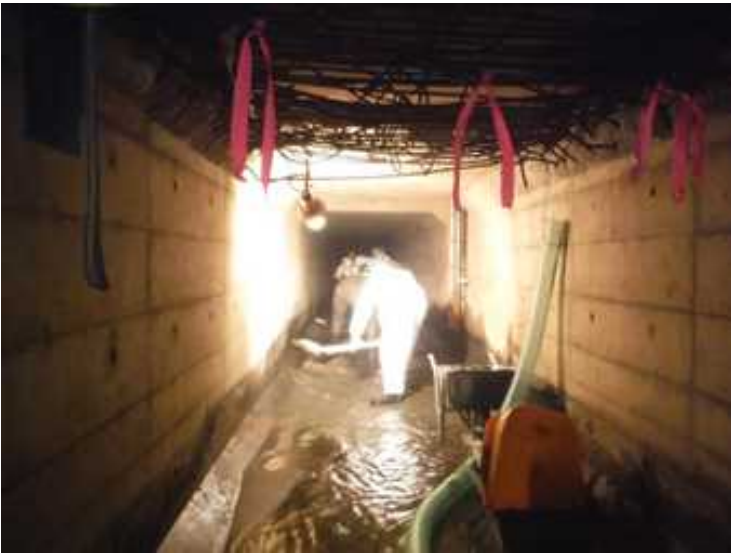
人力による暗渠内堆積物回収状況
