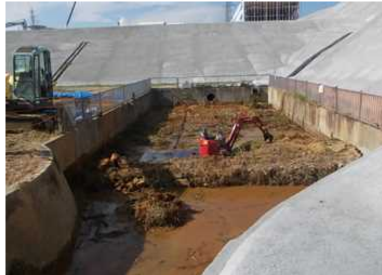
重機による排水路内堆積物回収状況
