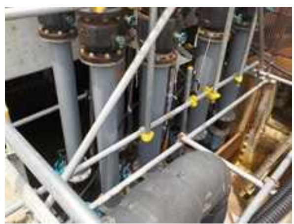
写真③：ポンプによる移送状況
