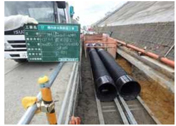
写真④：配管設置状況
