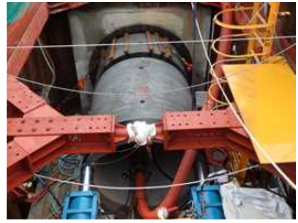
写真⑤：トンネル掘削状況
