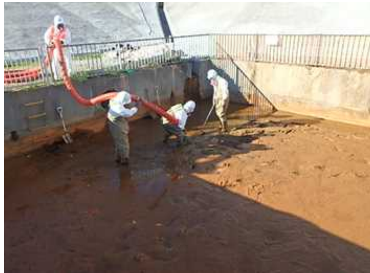
バキュームによる清掃状況
