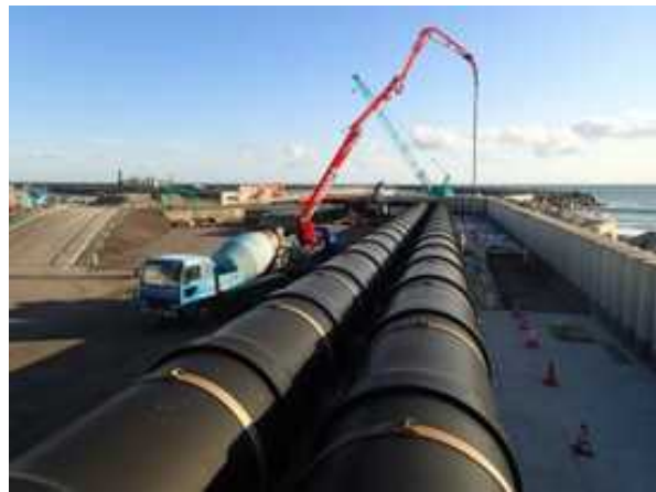
写真②：配管基礎工事状況
