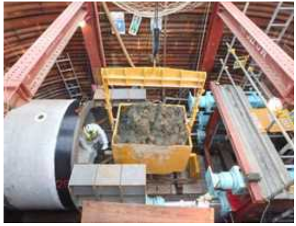
写真①：トンネル掘削状況
