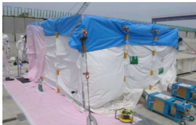
作業ハウス全景
