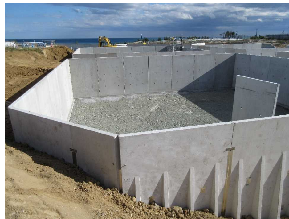
建設中の伐採木一時保管槽
