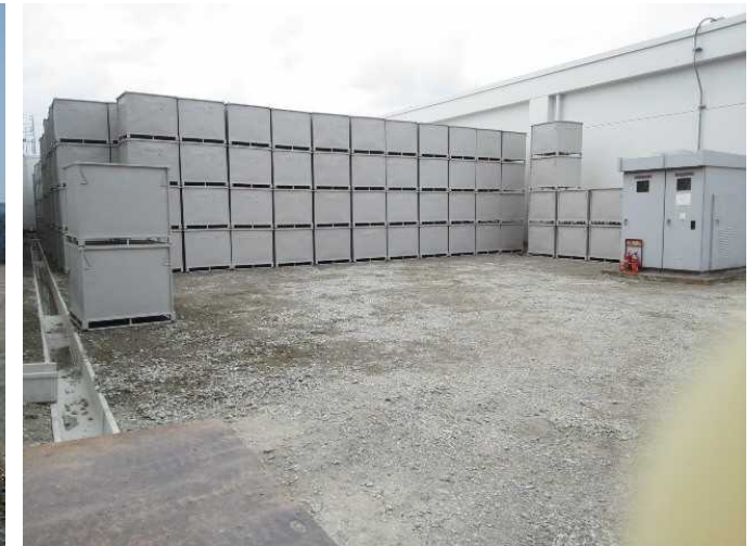
固体廃棄物貯蔵庫3, 4棟間 一時保管エリア
