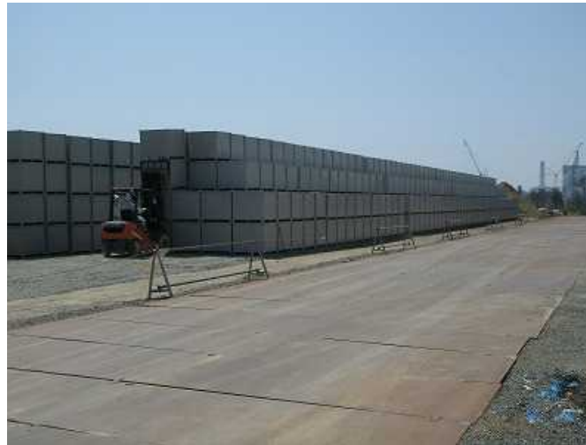
覆土式一時保管施設東側 一時保管エリア
