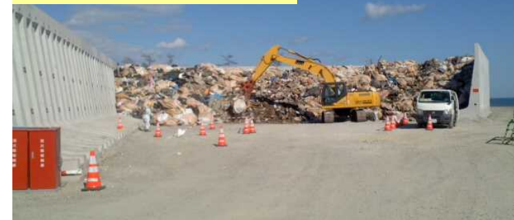
エリアP1の保管状況
