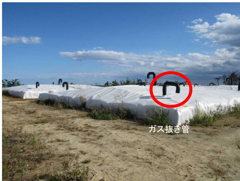
施工完了後の伐採木一時保管槽
