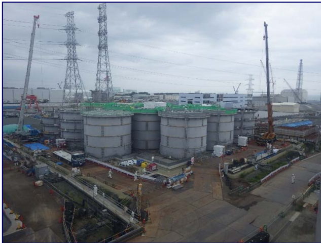
解体開始時の様子（6月19日撮影）
