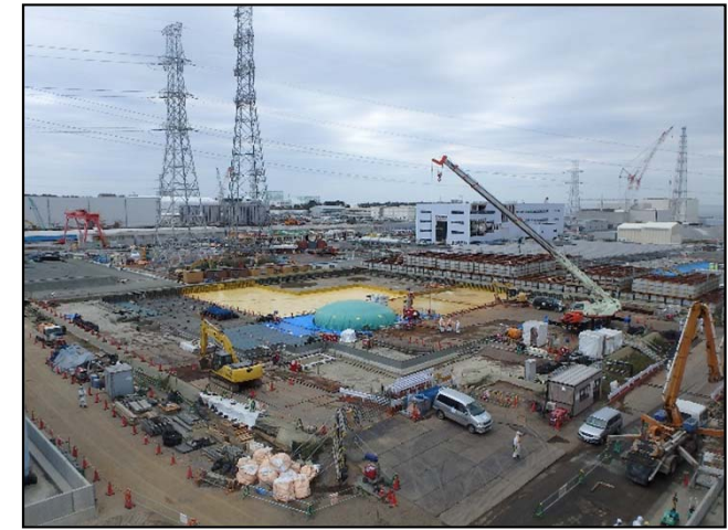
解体後の様子（10月29日撮影）
