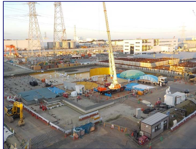
解体中の様子（10月28日撮影）
