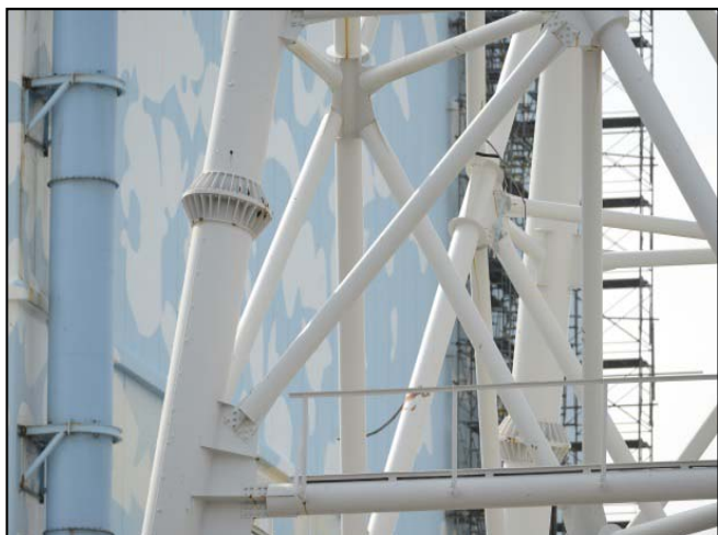
北側 (GL19 ~ 30m付近) 主柱・斜材
