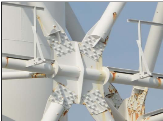
南側 (GL100m付近) 接合部
