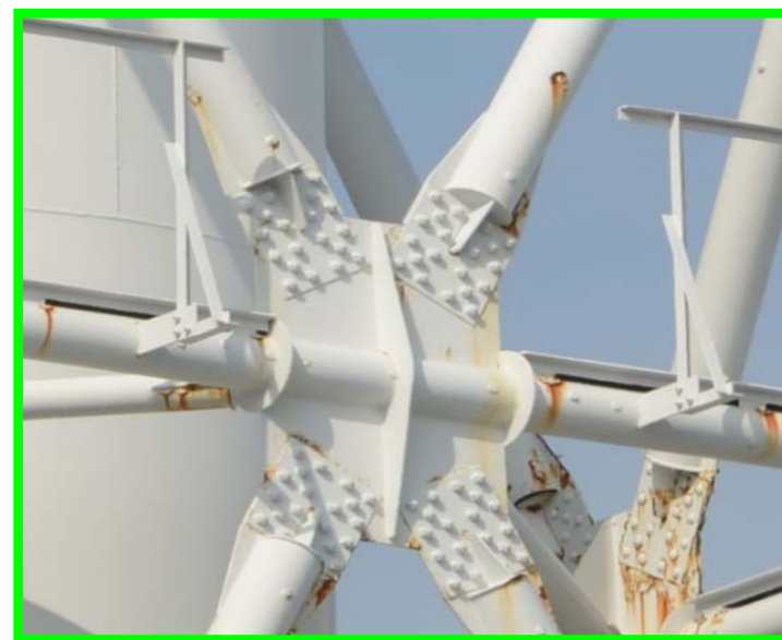
健全と判断した箇所の例（2015年9月）
