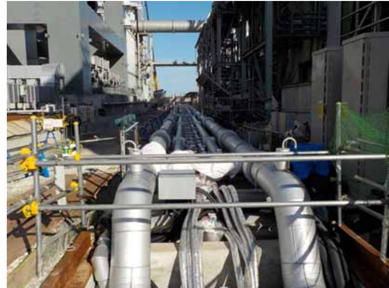
山側 (4号機建屋南側) 施工完了状況
