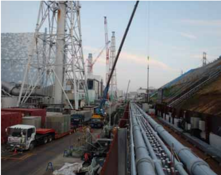
山側 (2~4号建屋西側) 施工完了状況
