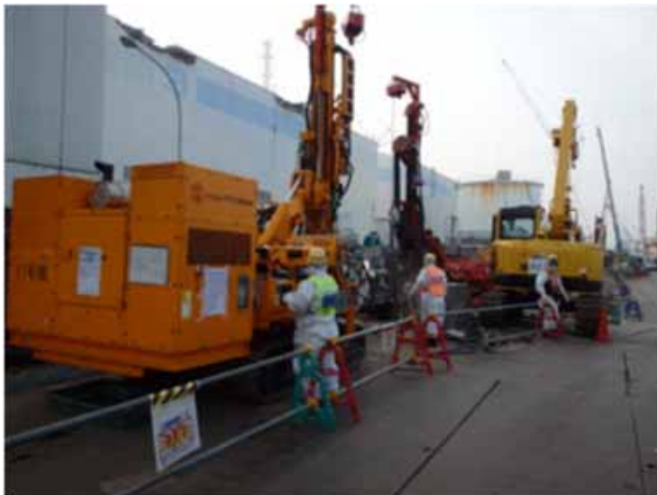
海側埋設構造物貫通施工箇所 削孔状況
