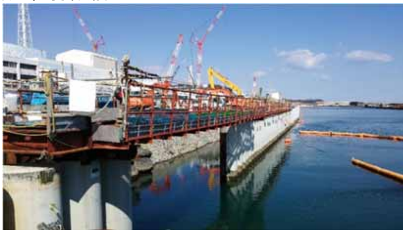
〈鋼管矢板打設前〉
