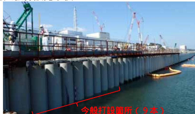
〈鋼管矢板打設完了後〉
