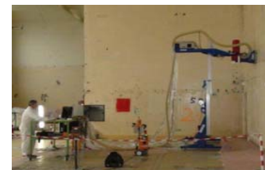
レーザー除染の様子
