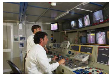
廃止措置遠隔作業監視室
