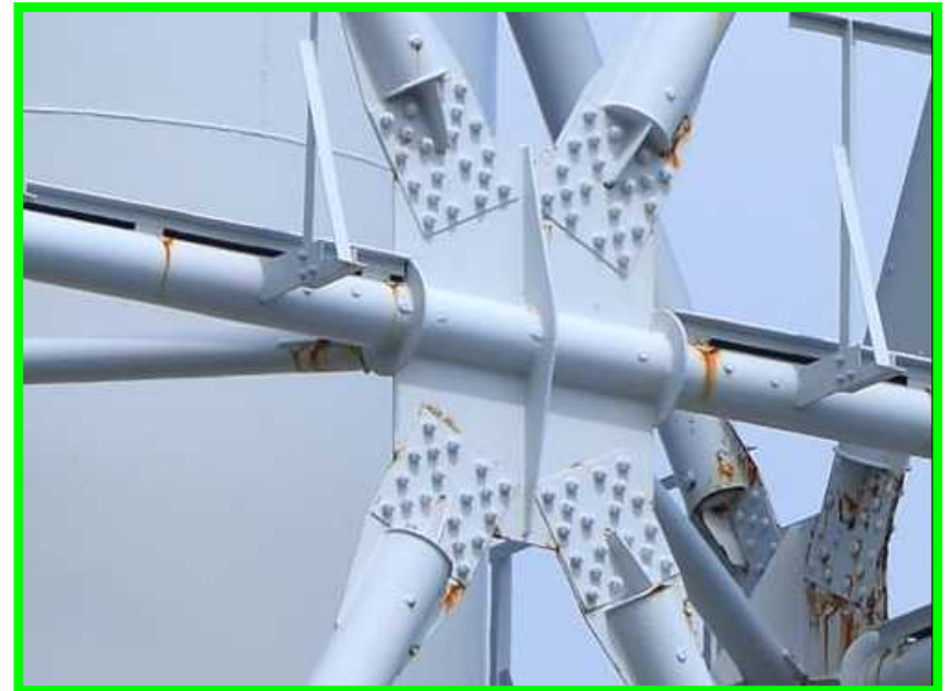
健全と判断した箇所の例
