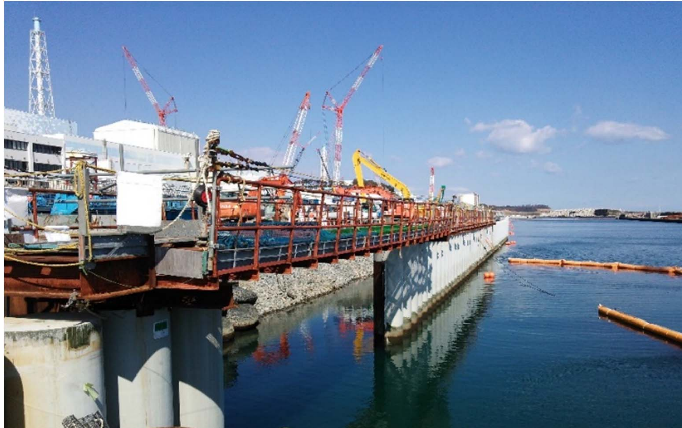
海側遮水壁閉合箇所：鋼管矢板9本分（延長約10m）
