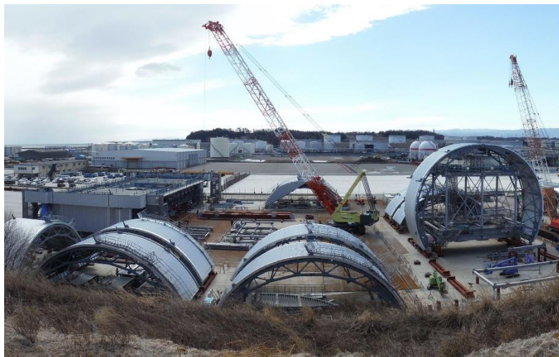
カバー架構部材の保管状況（2015.3.10撮影）
