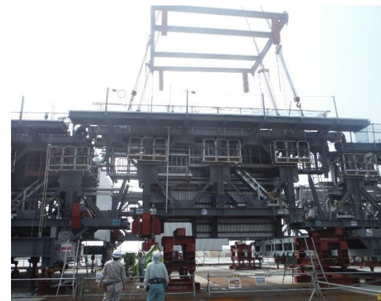
ガーダーの組立状況（2014.6.23撮影）
