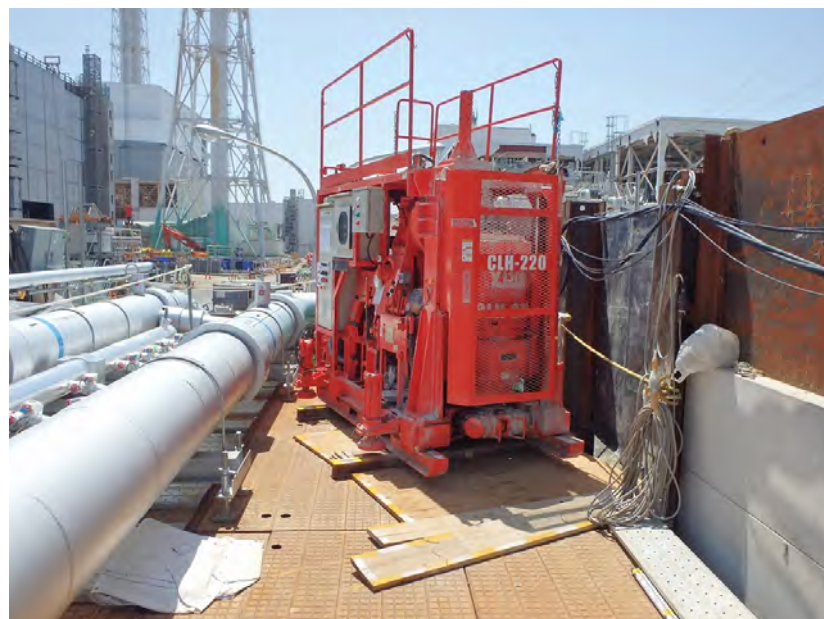
山側埋設構造物貫通施工箇所 削孔準備状況
