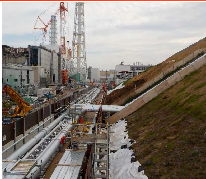
山側 (2~4号建屋西側) 施工状況
