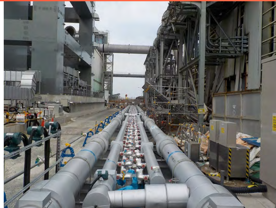
山側 (4号機建屋南側) 施工状況
