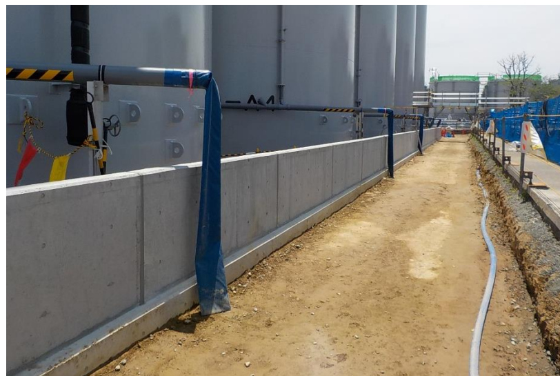
本堰設置状況
