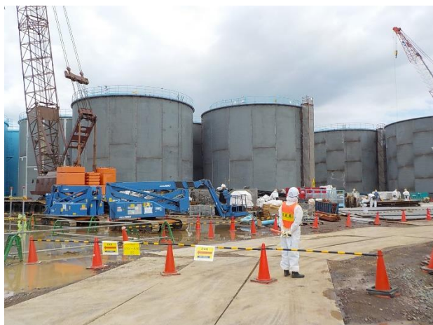
タンク建設状況
