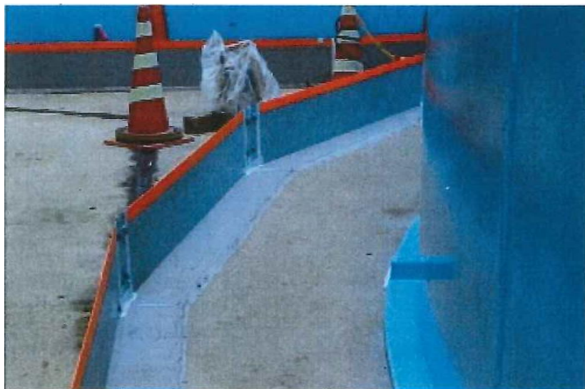
仮堰設置状況
