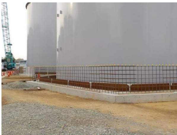
本堰建設状況
