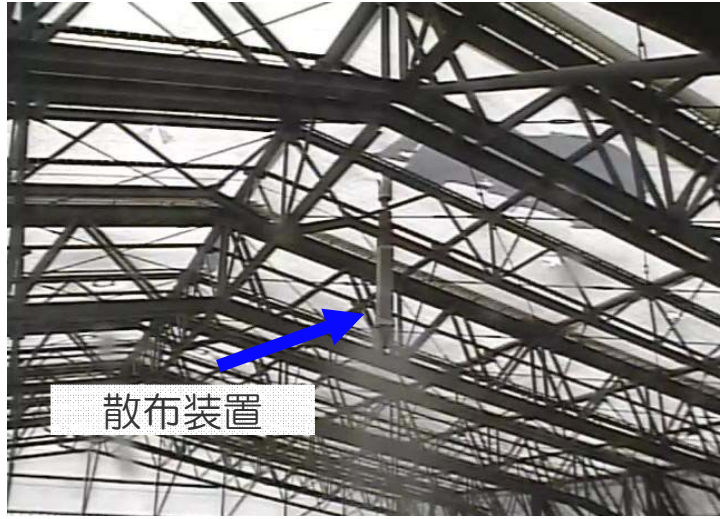
北2 屋根パネル飛散防止剤散布状況 (カバー内)
