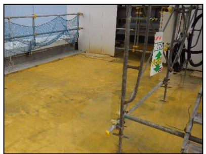
【写真③】ルーフブロック・敷砂撤去後 ストリップパルペイント塗布完了 (4月18日)
