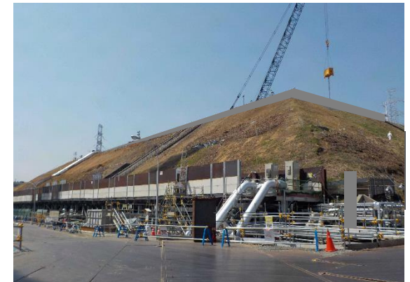
現場状況写真（写真②）
