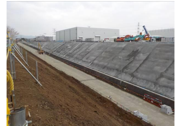
現場状況写真（写真②）
