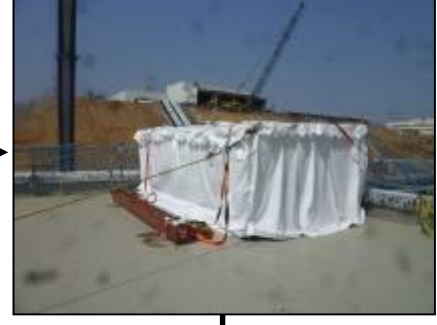
【写真④】仮設テント設置完了 (3月31日)
