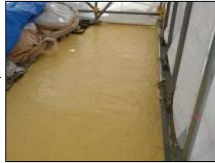
【写真⑦】仮設テント内ストリップパブルペイント塗布状況 (3月31日)
