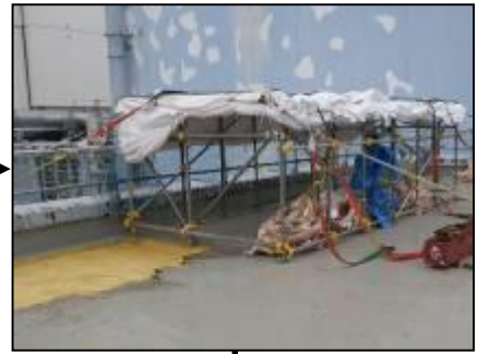
【写真⑧】仮設テント盛替状況 (4月1日)
