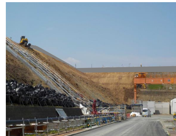
現場状況写真（写真②）
