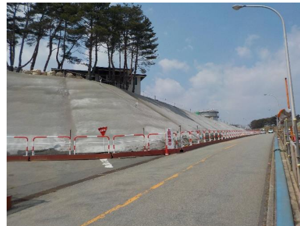
現場状況写真（写真①）
