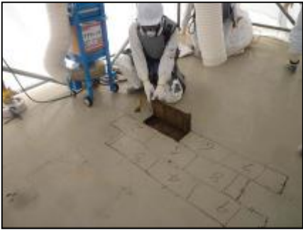
【写真⑤】汚染源撤去開始 (3月30日)
