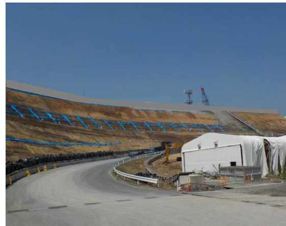
現場状況写真（写真①）
