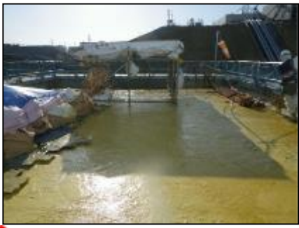
【写真⑨】ストリップパブルペイント塗布状況 (4月2日)
