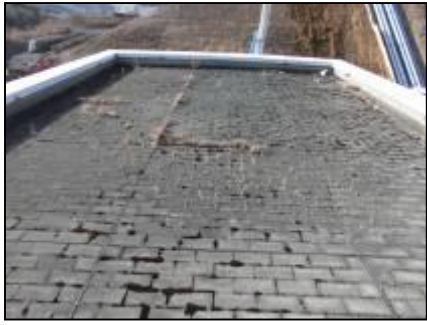
【写真①】作業前
