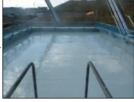
【写真⑦】仮設テント内ストリップパブルペイント塗布状況 (3月31日)
