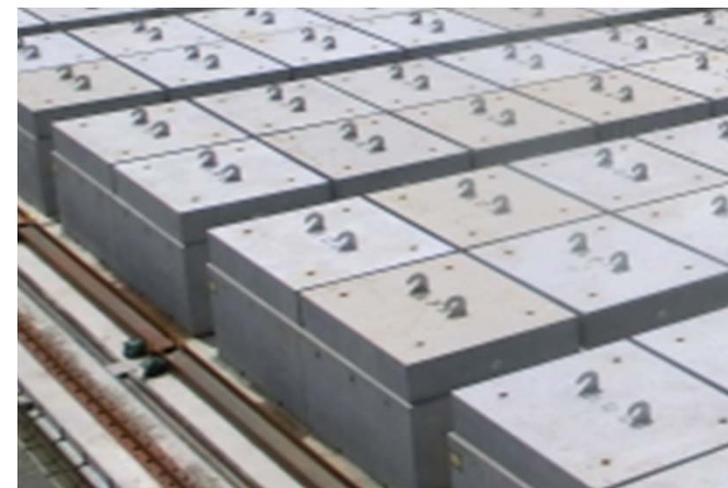
ボックスカルバートは鉄筋コンクリート造で高性能容器（HIC）2基を格納後、上部に遮へい用の鉄筋コンクリート厚蓋を配置する。
