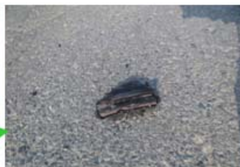
現場状況（路上①）
