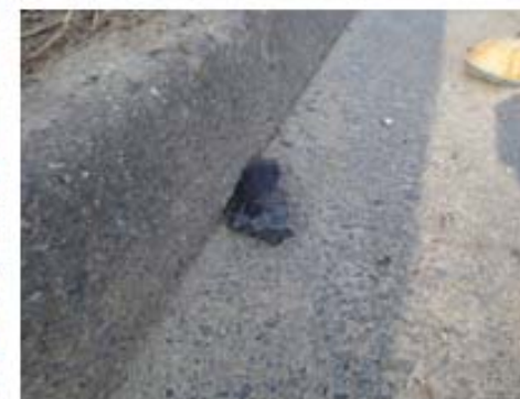
現場状況（路上③）
