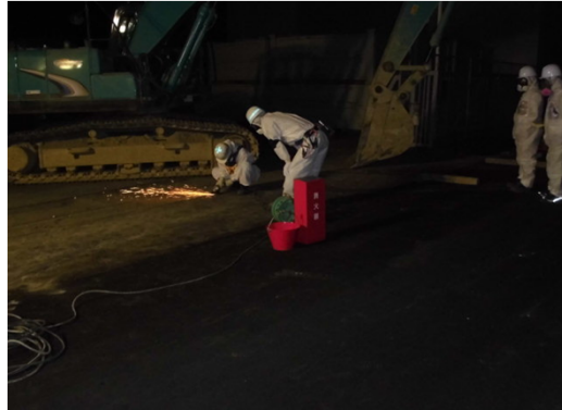
側溝上の鉄板の状況
