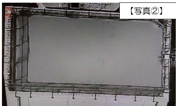
防水完了（3月14日）
