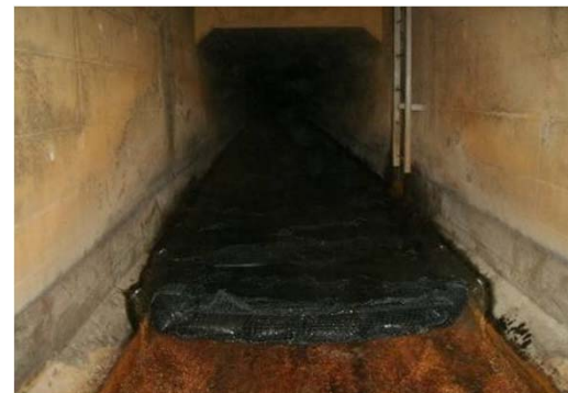
2/10撮影（K排水路）
