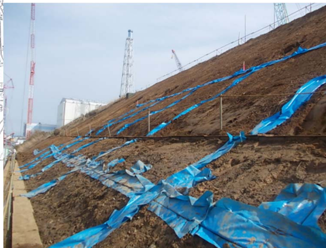
現場状況写真（撮影①）
