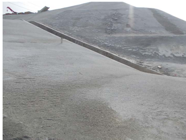
現場状況写真（撮影①）
