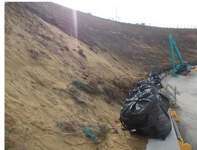
現場状況写真（撮影①）
