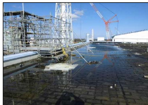
写真②：2号R/B屋上
