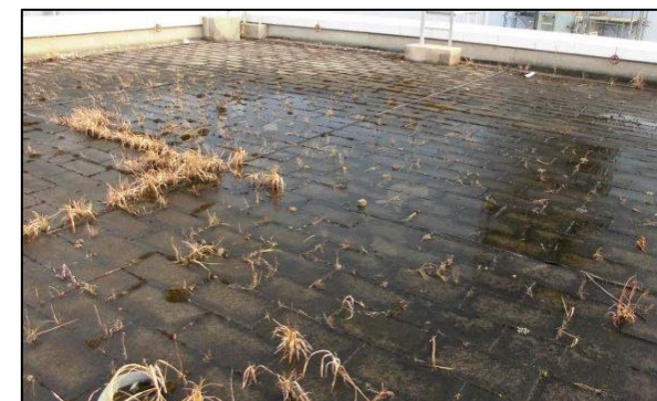
写真④：大物搬入口屋上
