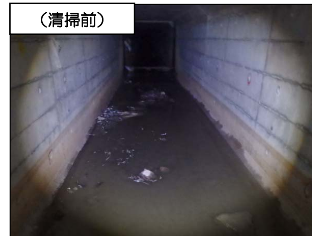
【写真③】 K排水路内部
