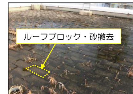
ルーフブロック・砂撤去予定
