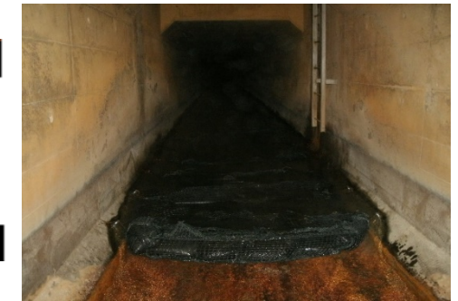
2/10撮影（K排水路）
