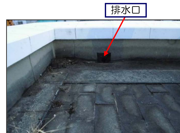
ゼオライト土嚢 設置前
