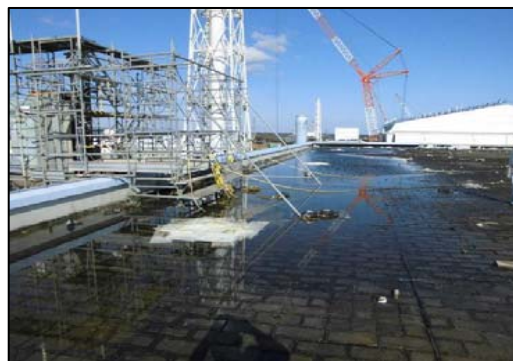
写真②：2号R/B屋上
