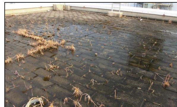
写真④：大物搬入口屋上
