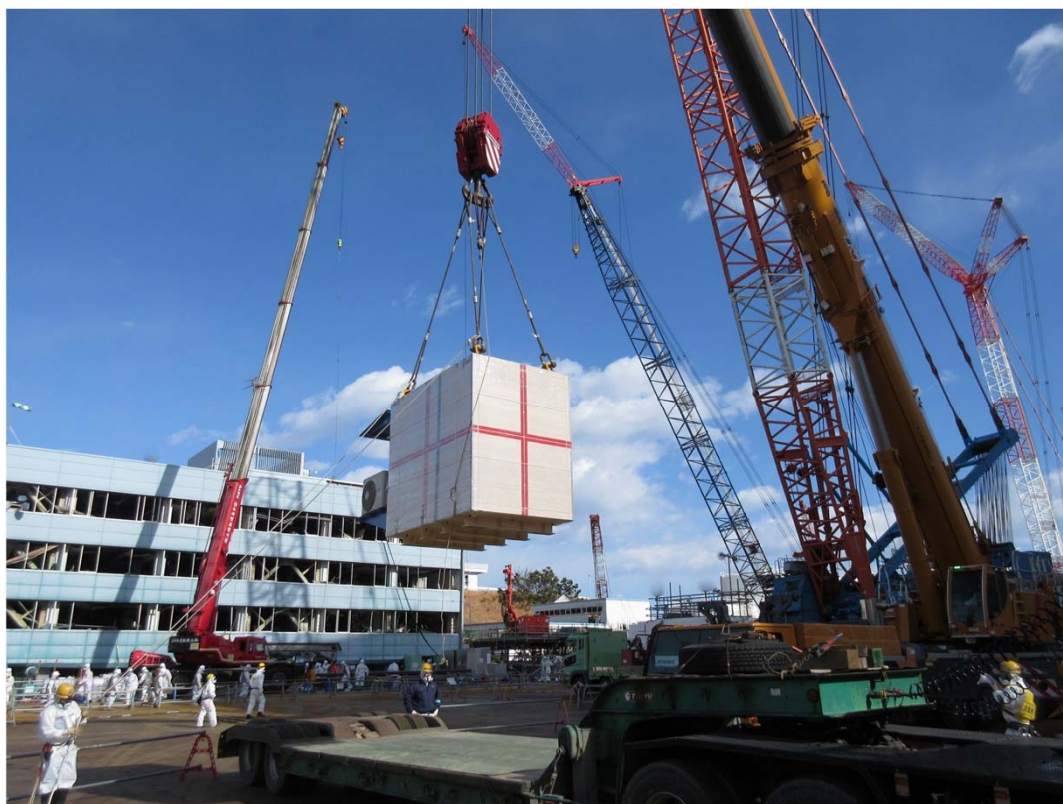
設置状況①
