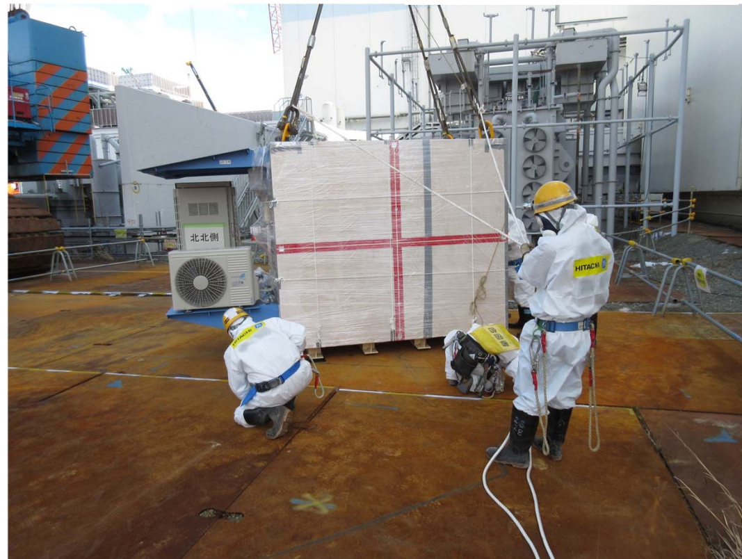
設置状況②
