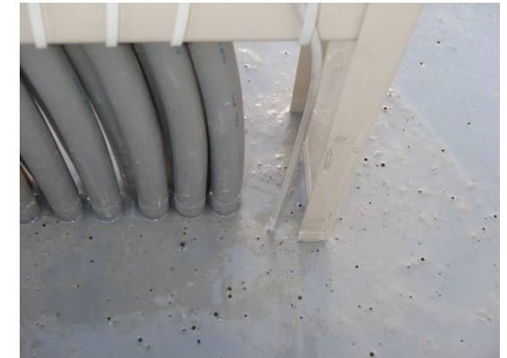
ケーブル間充填 確認状況
