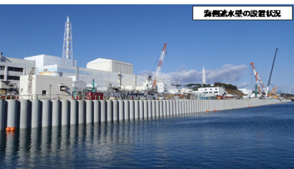
海側遮水壁の設置状況
