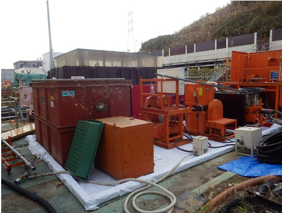
充填材(可塑性グラウトモルタル)プラント設置状況
