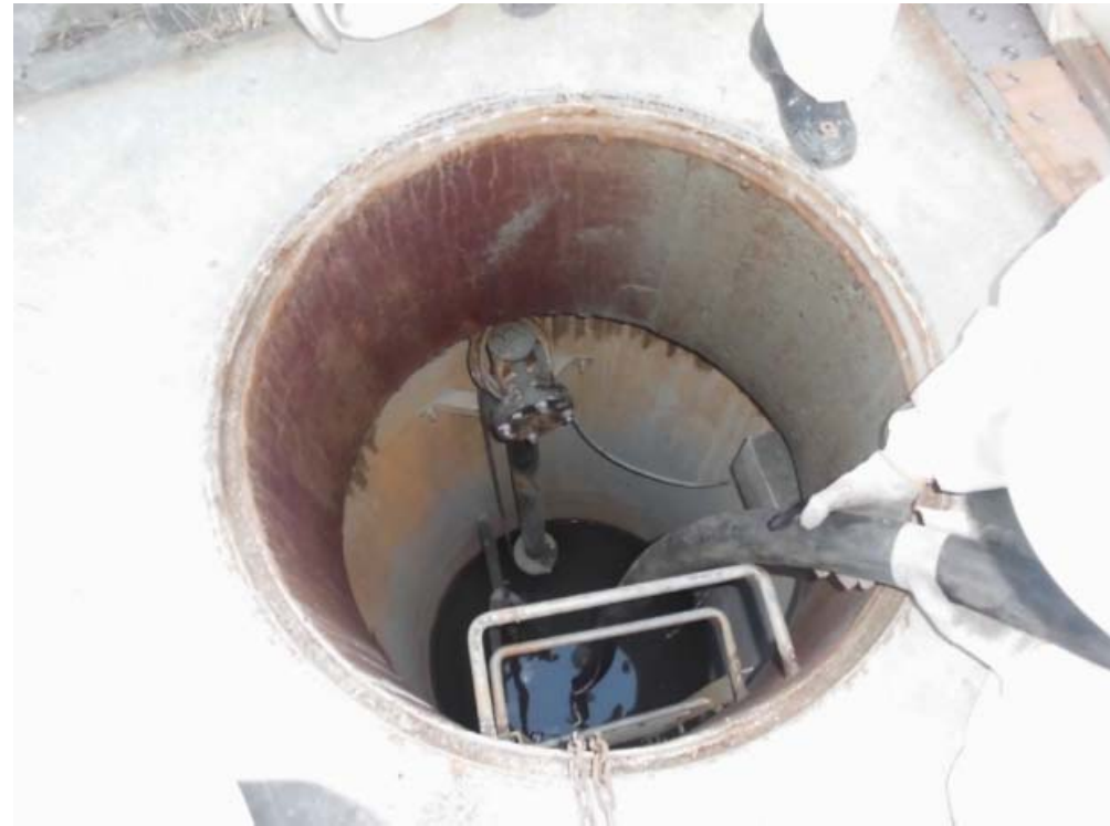
充填材打設状況
