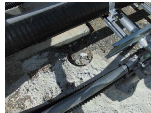
No. 49ピットの状況 (H26.10時点)
