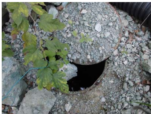
No. 47ピットの状況 (H26.10時点)
