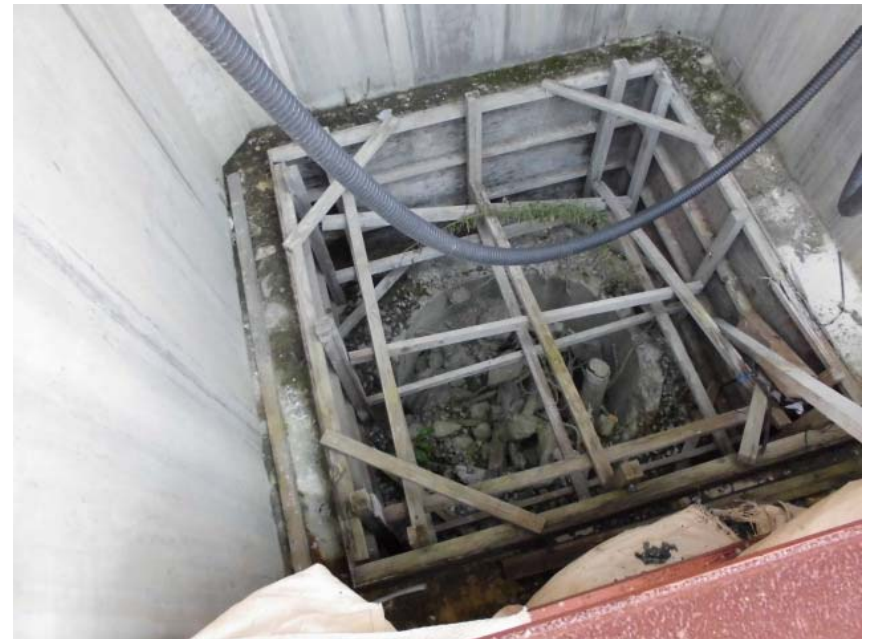
No. 39ピットの状況 (H26.10時点)
