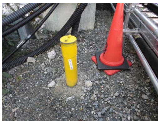
No. 48ピットの状況 (H26.10時点)
