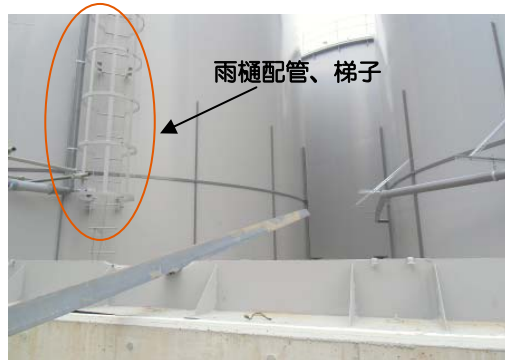
J1エリアタンク、雨樋配管、梯子について目視点検を行い異常なし。
