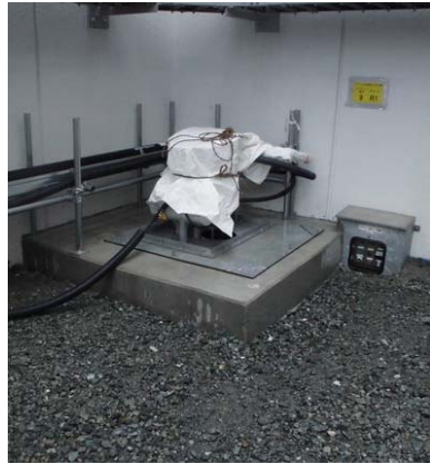
サブドレンピット
