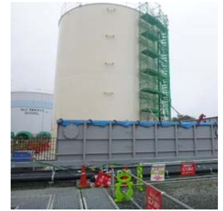
一時貯留タンク
