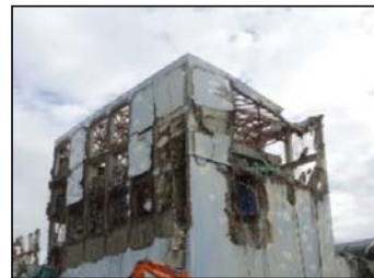
①原子炉建屋ガレキ撤去作業前
