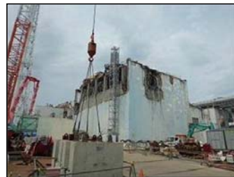
②原子炉建屋ガレキ撤去作業後
