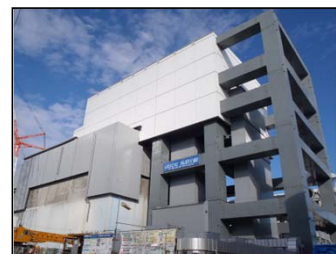
④燃料取り出し用カバール完成
